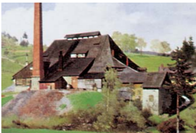
リーデル社、最初の工場(1760年)。森の中のガラス工房だった時代である。
