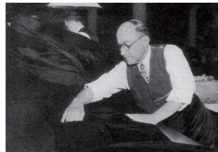
ブルックリンのネイバルヤード内に置かれたクロージングファクトリーでピーコートを製造している様子を捉えた貴重な記録写真。最終点検の作業風景か。Photo / WPP Archives
